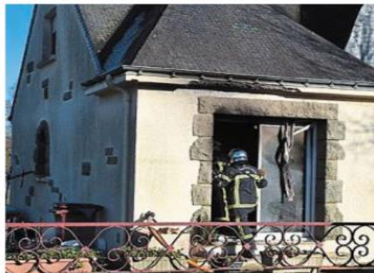
Les pompiers sont intervenus sur un feu de cheminé.
